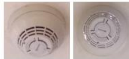
อุปกรณ์ตรวจจับควัน (smoke detector)
